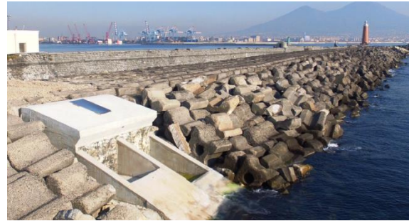
Figura 36 - Progetto DIMEMO (Diga Marittima per l'Energia del Moto Ondoso)
